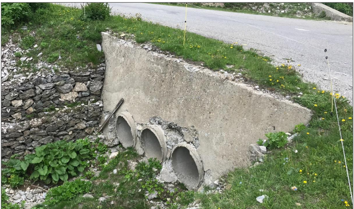
Figure 10 – Franchissement n°4 – pK 1.79 – Photos amont de l'ouvrage
