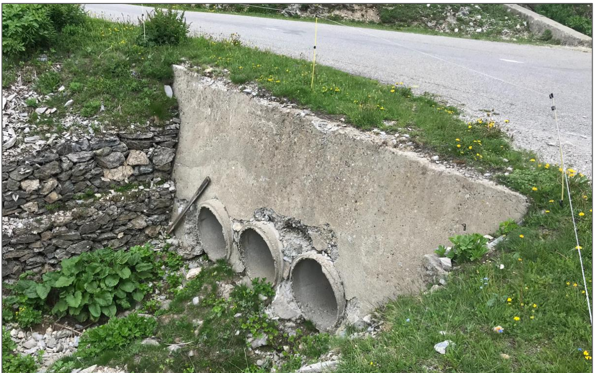
Figure 8 – Franchissement n°2 – pK 1.35 – Photos amont & aval de l'ouvrage
