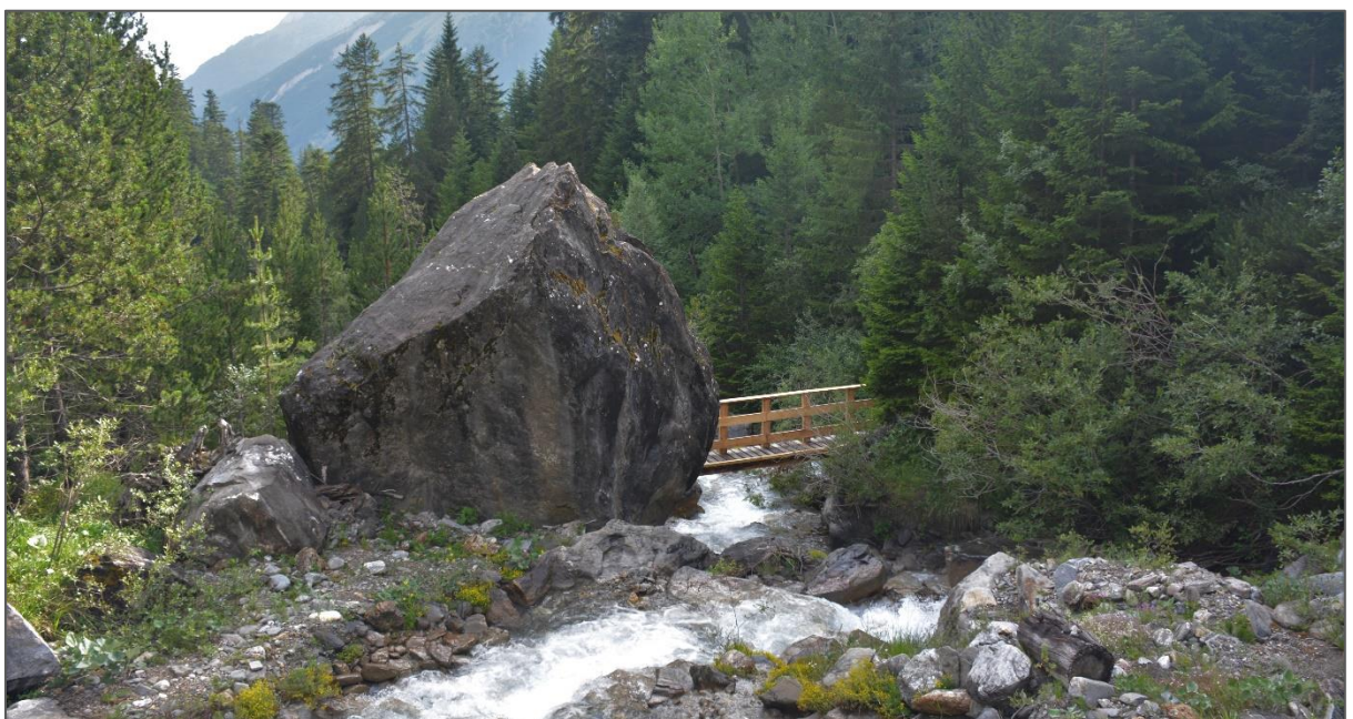
Figure 14 – Franchissement « Passerelle » – pK 3.80 – Photos amont et aval de l'ouvrage
